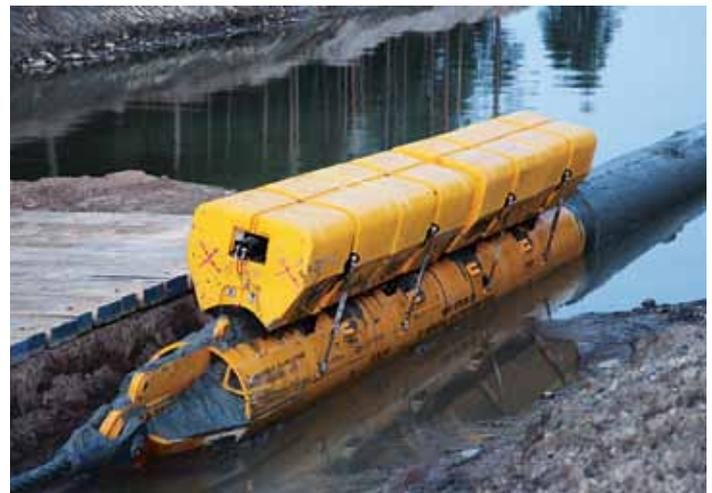
Die Spitze der Pipeline wird mit einer Zugvorrichtung versehen, an der ein Stahlkabel befestigt wird. Eine Boje hält die Spitze über Wasser.
