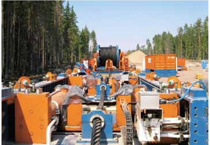
Die Pipelinestränge wurden mittels einer Hochleistungszugwinde an Land gezogen. Die Winde wiegt 100 Tonnen.
